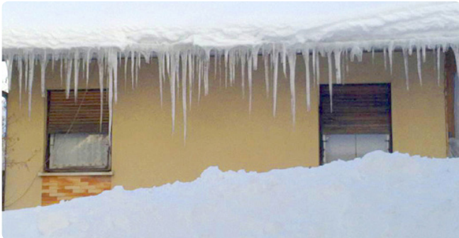
Ledene sveče so pogosto posledica pomanjkljive toplotne zaščite strehe
